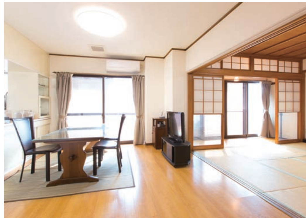
南側に面して直射日光が当たりやすいLDKと広縁の窓に内窓 インプラスを設置。住まい全体の天井裏に断熱材を入れた。
