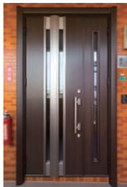
玄関の開口部からの熱気や冷気の出入りを少なくするため、寒冷地仕様の玄関ドアを採用。縦長のスリット窓付きで、玄関ホールへの採光も確保。玄関ドア:リジェント(LIXIL)
