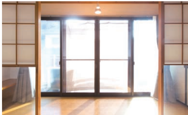
内窓 インプラスを取り付けた広縁の掃き出し窓。
