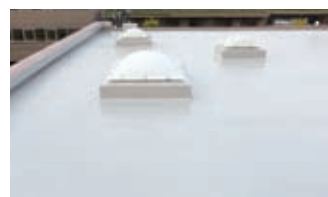
屋根には遮熱塗料を塗って、直射日光による影響が少なくなるようにした。サーモグラフィーカメラで表面温度を測定したところ、塗装前と塗装後で10℃以上温度差があった。屋上遮熱塗装・水性ボストップクール(ススカ)
